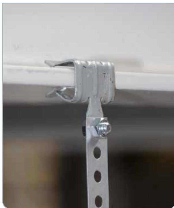
Montagebeugel aan spant ▲
