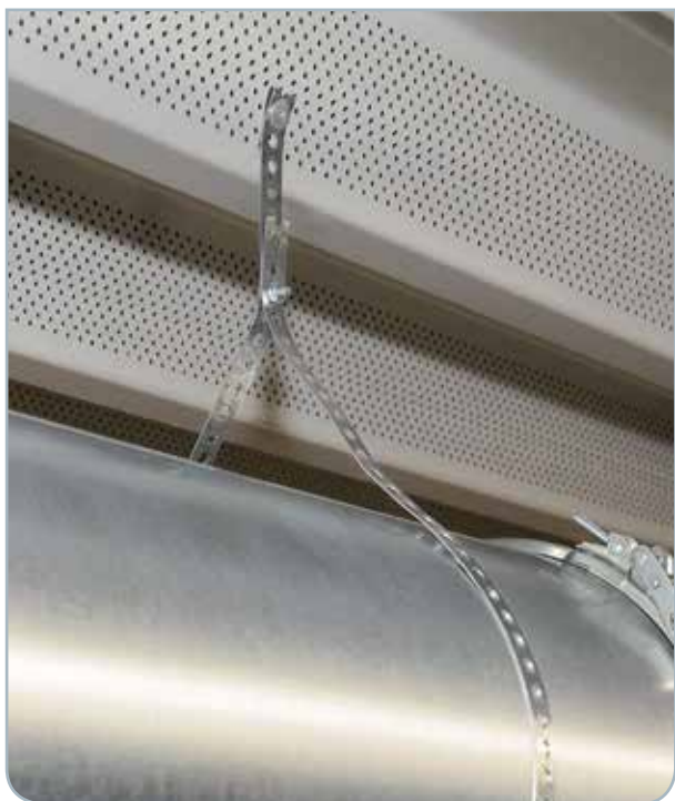
Montageband aan dak ▲
